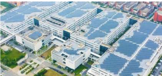
太阳能光伏系统
